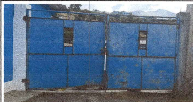
Foto 4. Sustrución de portón de metal por metal
