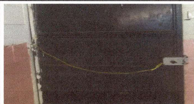
Foto 3. Sustrución de puerta
