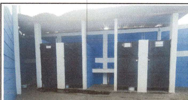
Foto 6: Mantenimiento a estructura (lijado, cambio de tubo, cepillado, sujeciones, aplicación de pintura) a puertas de servicios sanitarios
